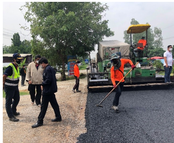
ภาพที่ 7 การก่อสร้างแปลงทดสอบ กม.6+000 - กม.7+000
