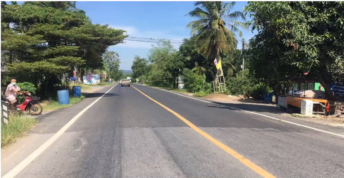
ภาพที่ 8 การก่อสร้างแปลงทดสอบ กม.6+000 - กม.7+000
